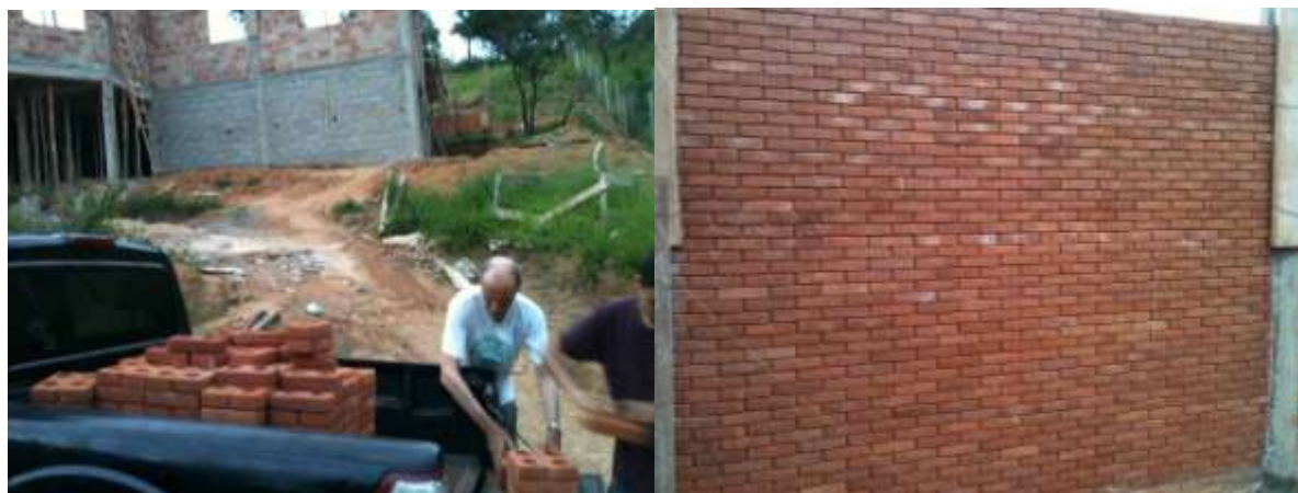
Figura 18 - Entrega da 1ª venda e tijolos já instalados na obra (Jan/2013)
