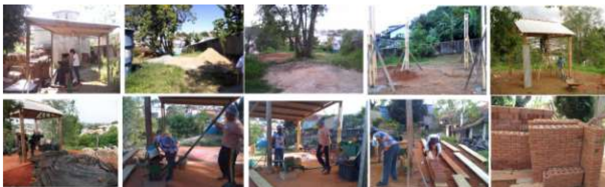
Figura 14 - Sequência de fotos (No sentido horário a partir da Esq. em cima) - Local das primeiras instalações / Local para ampliação / Construção Galpão / Construção Galpão (2) / Construção Galpão (3) / Galpão Construído com máquinas / Capacitação em produção de tijolos com voluntários de Cambuquira (1) / Capacitação em produção de tijolos com voluntários de Cambuquira (2) / Tijolos produzidos imediatamente pós-prensa / Tijolos prontos.
