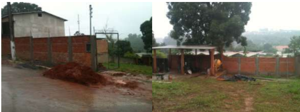
Figura 17 - Instalações da nova fábrica de tijolos no bairro Nova Estação (Jan/2013)
